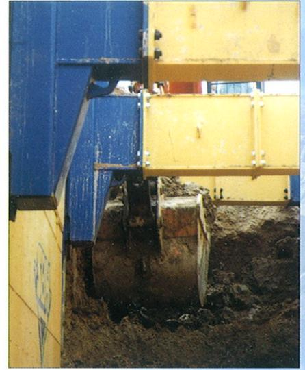
El monocodal de patines soporta bien los esfuerzos de torsión que se presentan en zanjas de anchura considerable. Las altas presiones laterales del terreno, se absorben por la pieza horizontal del monocodal. Los momentos en el pórtico H no suponen ningún problema de deformación.
