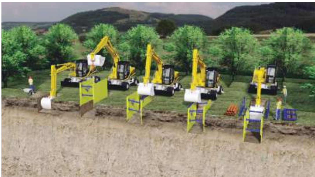
Fig. 28: Descenso progresivo de la entibación. Ejemplo con ESTÁNDAR BOX serie 600
