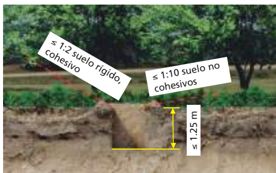
Fig. 16: Vertical, profundidad \leq 1.25 m en suelos no cohesivos, blandos o rígidos, suelos cohesivos
