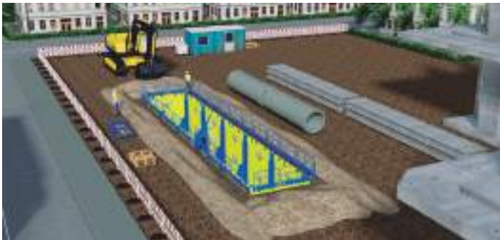
Fig. 19: Descenso progresivo en suelos no fluentes. La profundidad determina la altura de la entibación
