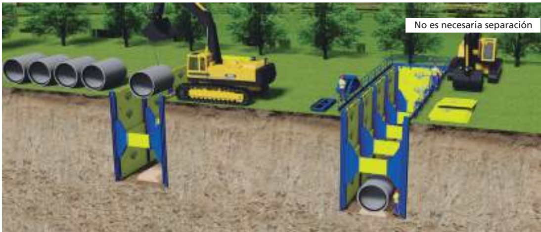
Fig. 22: Zanjas y pozos con entibación
