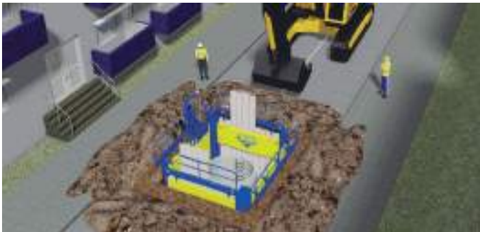
Fig. 20: Pozo entibado en suelo no fluente. La profundidad determina la altura de la entibación
