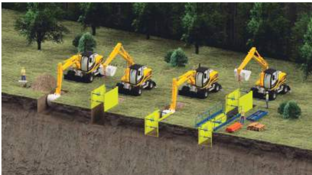
Fig. 27: Descenso directo de la entibación. Ejemplo con ENTIBACIÓN LIGERA Serie 100
