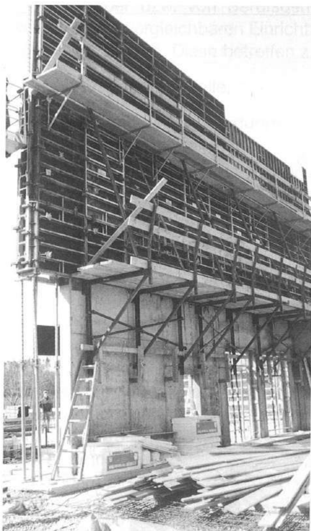
Figura 40. Ménsulas de Trepado
