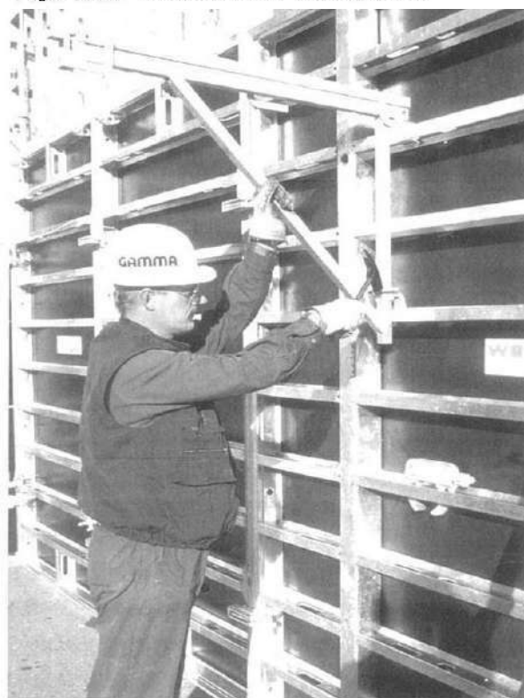
Figura 37 Ménsula de Hormigonado
