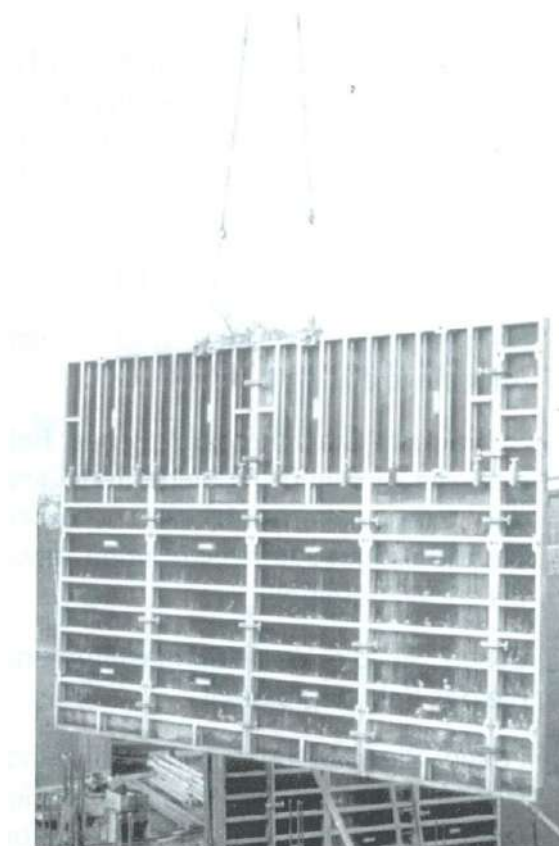
Figura 52 Desmontaje con grúa
