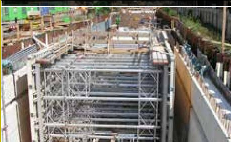
Encofrados móviles
